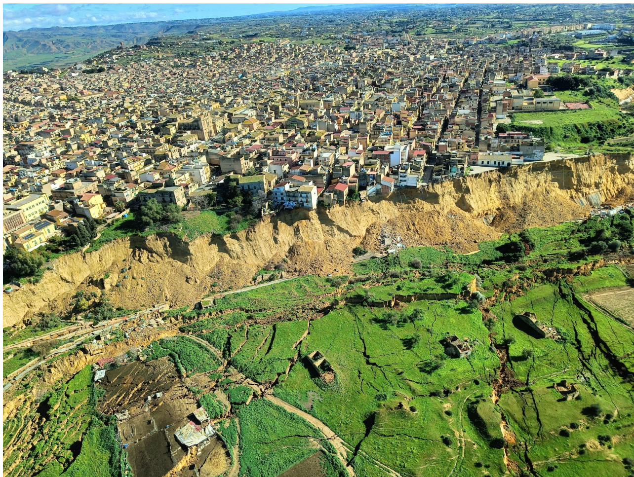
Figura 17 - Particolare della scarpata principale della frana di Niscemi nella zona del quartiere Sante Croci. Immagine acquisita durante il sopralluogo da elicottero del 27 gennaio 2026 che mostra l'evoluzione in atto della scarpata con formazione di cono detritici.
