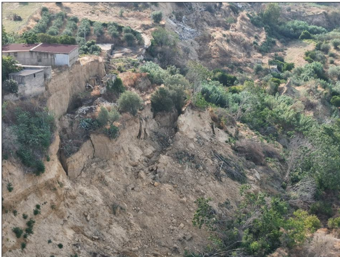
Figura 6 - Settore di via Ustica: veduta del coronamento della frana, arretrato in modo repentino e in massa (fino a circa 25 m rispetto all'ultimo rilievo della Fondazione CIMA). È riconoscibile una struttura a Graben incipiente (foto del 29 luglio 2026). Foto fornita da DRPC.
