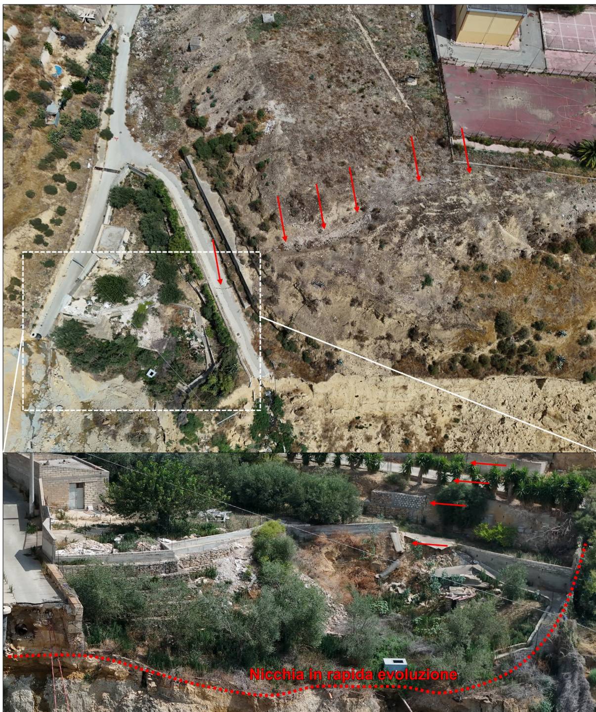
Figura 45 - In alto, vista aerea della fessura antistante il plesso scolastico San Giuseppe; in basso, dettaglio della sua terminazione nei pressi della nicchia in rapida evoluzione al confine con l'area del quartiere Sante Croci. Foto del sorvolo da drone eseguito dal Comune e fornite da DPC.
