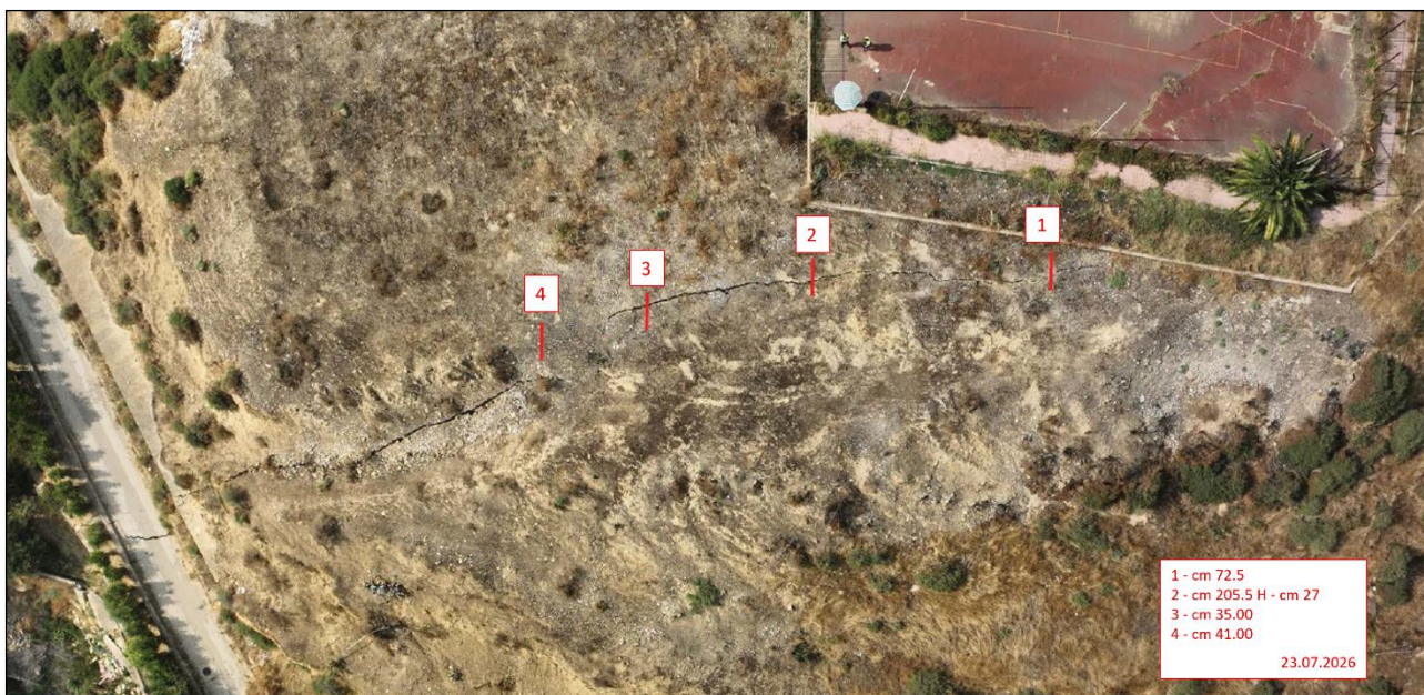
Figura 4 - Ubicazione dei quattro capisaldi di misura a lettura manuale e relativi valori di distanza misurati il 23 luglio 2026 (valori in cm; H indica il dislivello verticale misurato al punto 2). Foto e dati forniti da DPC.
