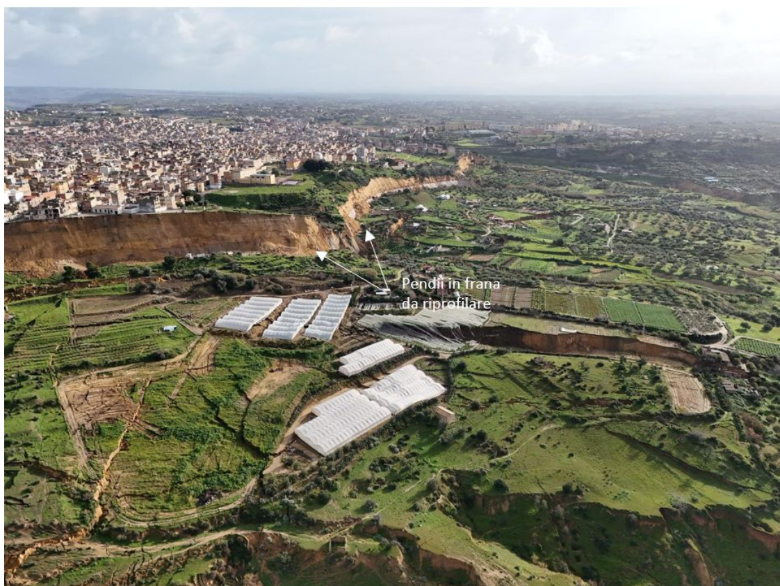
Figura 257 - Vista dei pendii in frana da riprofilare mediante eventuale impiego di terre armate.
