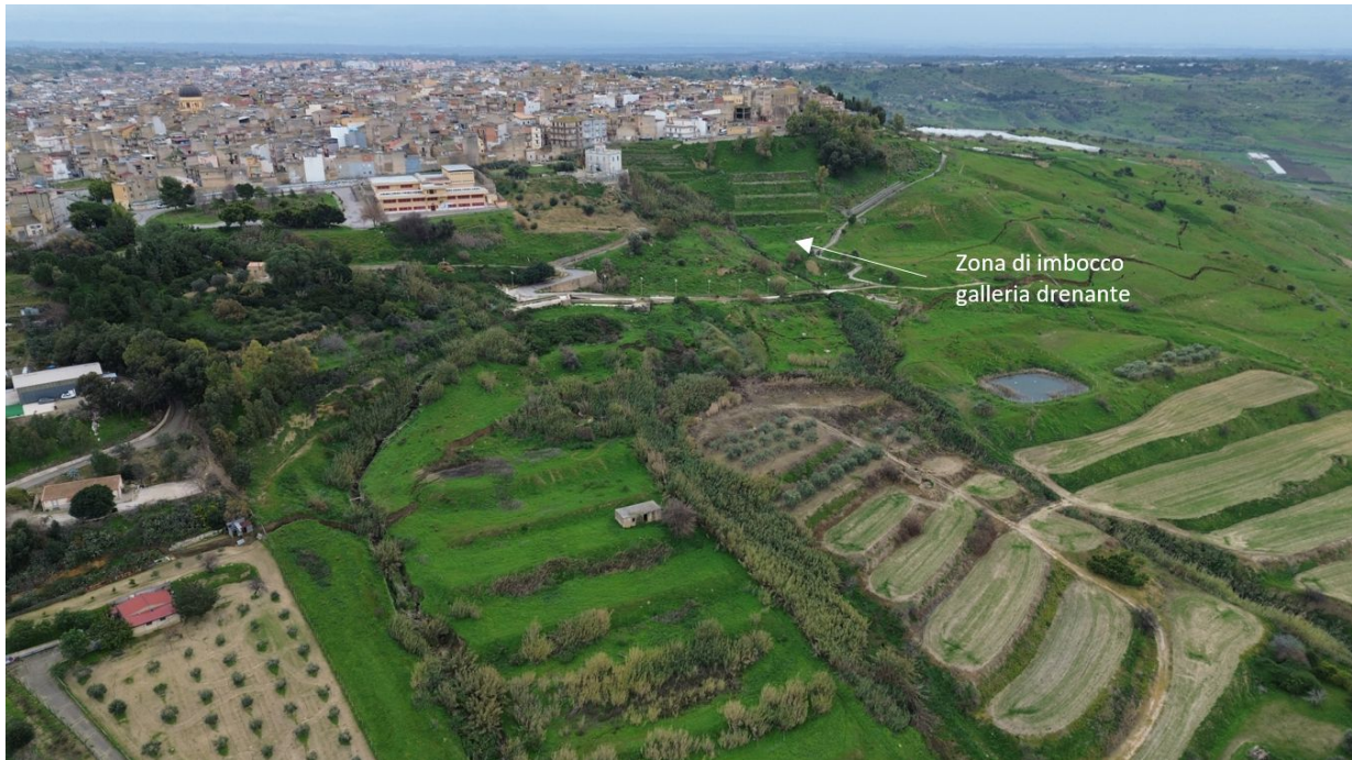
Figura 241 - Zona di imbocco della galleria drenante.
