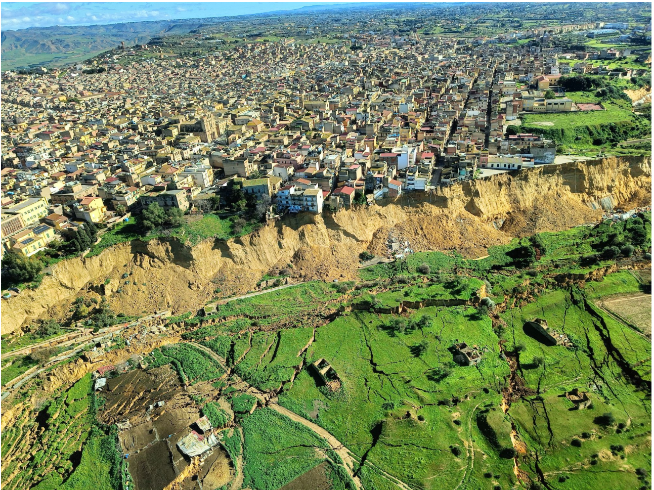
Figura 200 - Particolare della scarpata principale della frana di Niscemi nella zona del quartiere Sante Croci. Immagine acquisita durante il sopralluogo da elicottero del 27 gennaio 2026 che mostra l'evoluzione in atto della scarpata con formazione di coni detritici.
