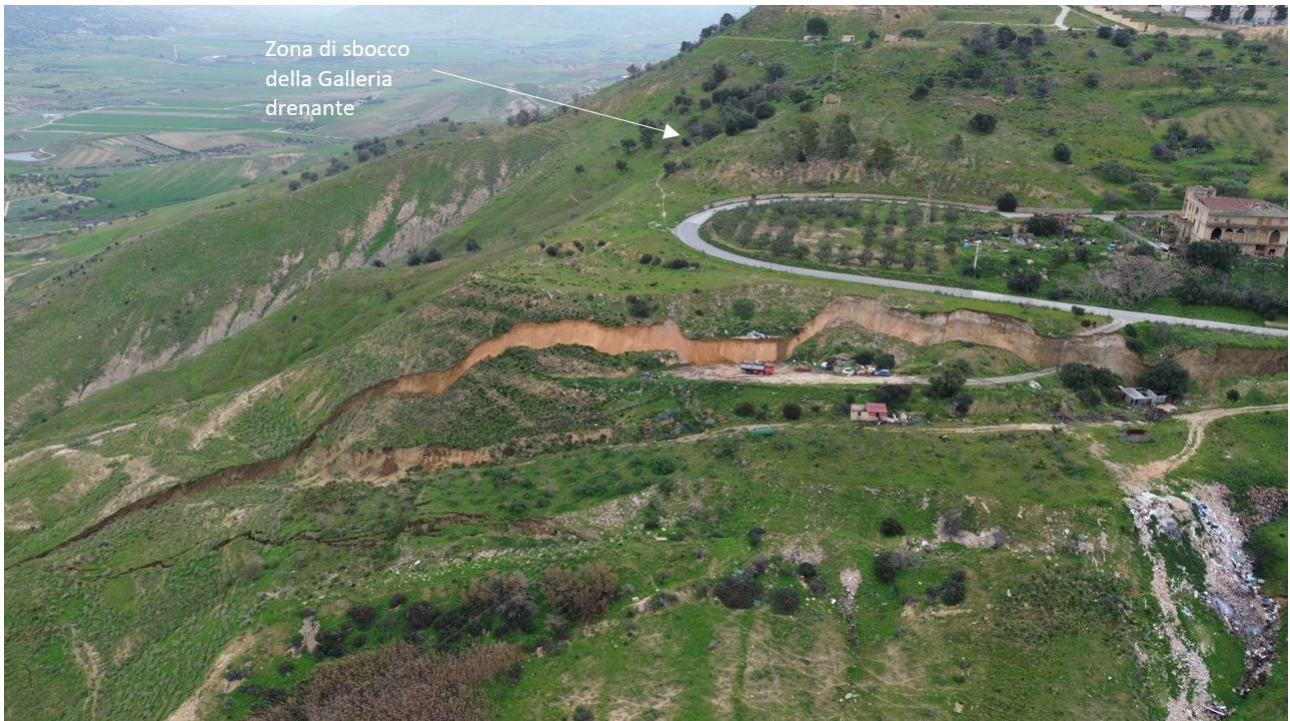
Figura 225 - Zona di sbocco della galleria drenante
