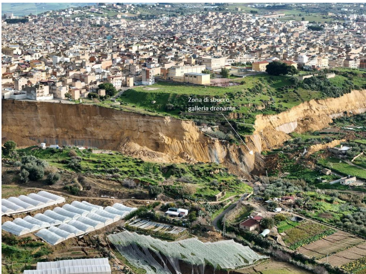
Figura 242 - Zona di sbocco della galleria drenante.
