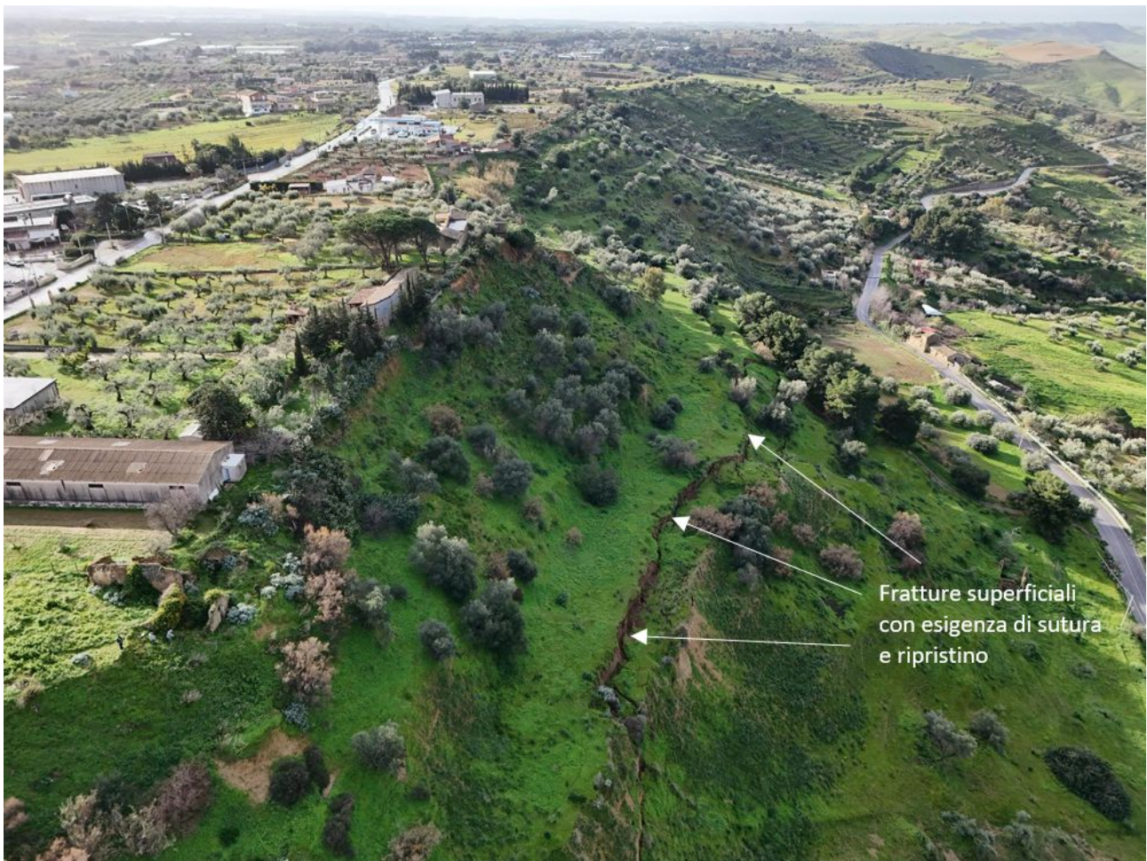
Figura 275 - Evidenza delle fratture superficiali con esigenza di sutura e ripristino.
