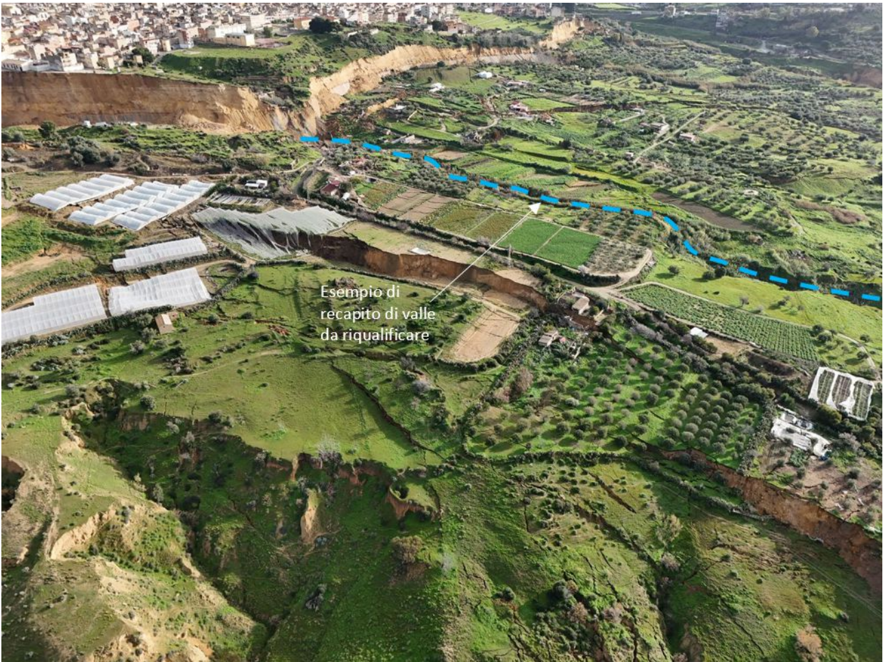
Figura 254 - Vista della zona di valle del pendio con indicazione della riqualificazione dei recapiti superficiali.
