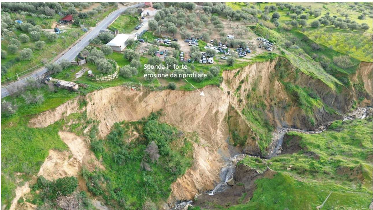
Figura 291 - Sponda in sinistra idraulica al torrente Benefizio in forte erosione, da riprofilare mediante impiego di gabbioni e sistemi di protezione dall'erosione superficiale.
