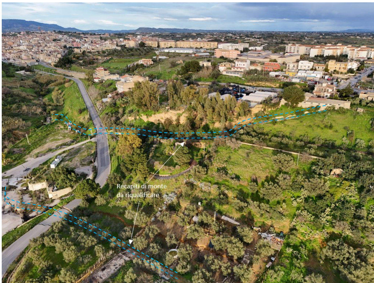
Figura 267 - Versante di monte della SP10 con necessità di sistemazione dei recapiti superficiali e di introduzione di sistemi di drenaggio profondi per la corretta regimazione delle acque di infiltrazione.
