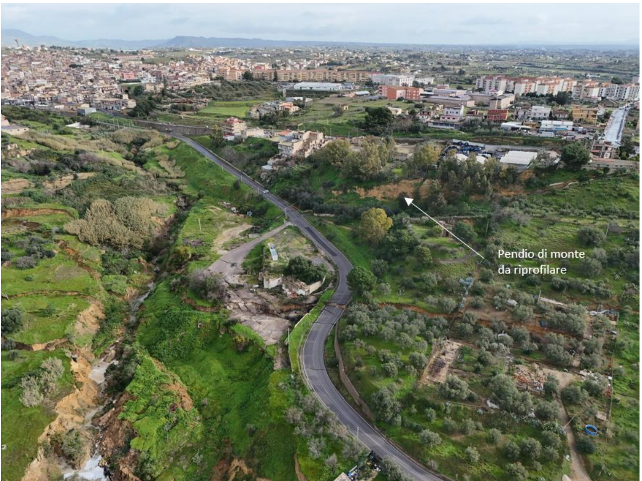
Figura 271 - Vista dei pendii di monte della SP10 con necessità di riprofilatura mediante eventuale impiego di terre armate.
