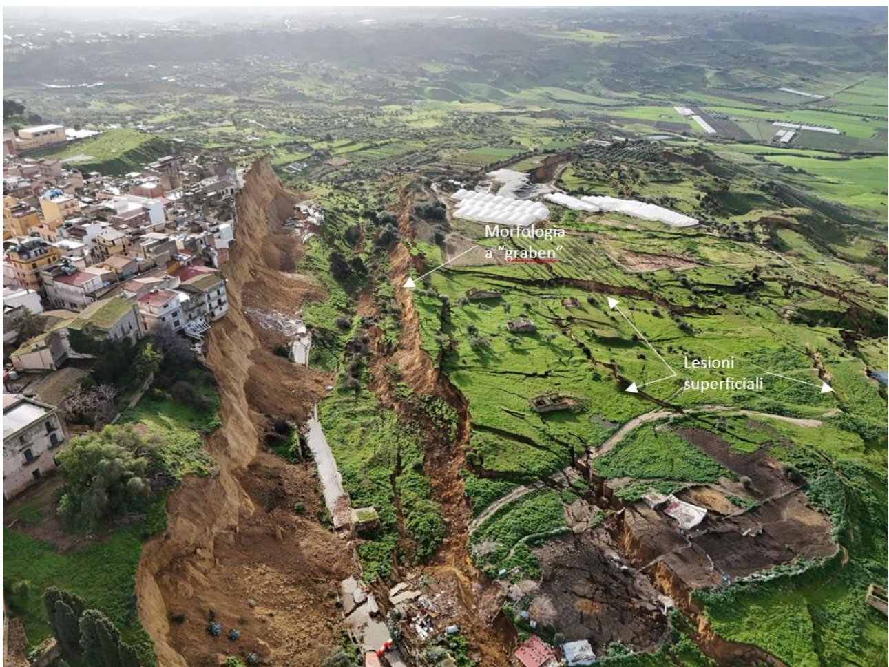
Figura 261 - Zona di valle della frana con evidenza del movimento al piede per effetto Graben e delle fratture diffuse verso valle.
