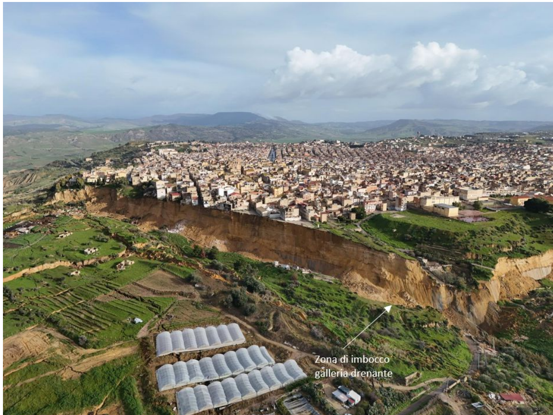
Figura 246 - Zona di imbocco della galleria drenante.
