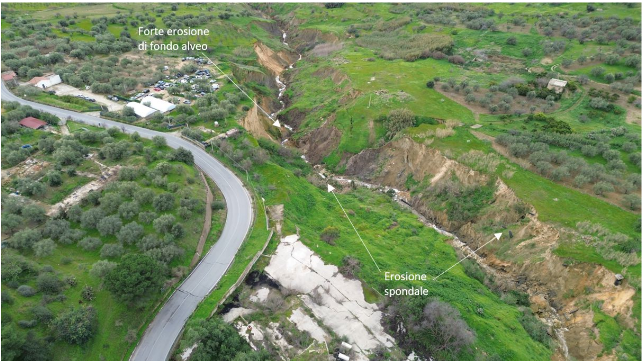
Figura 278 - Alveo e superfici spondali del torrente Benefizio in evidente stato di erosione e dissesto diffusi.
