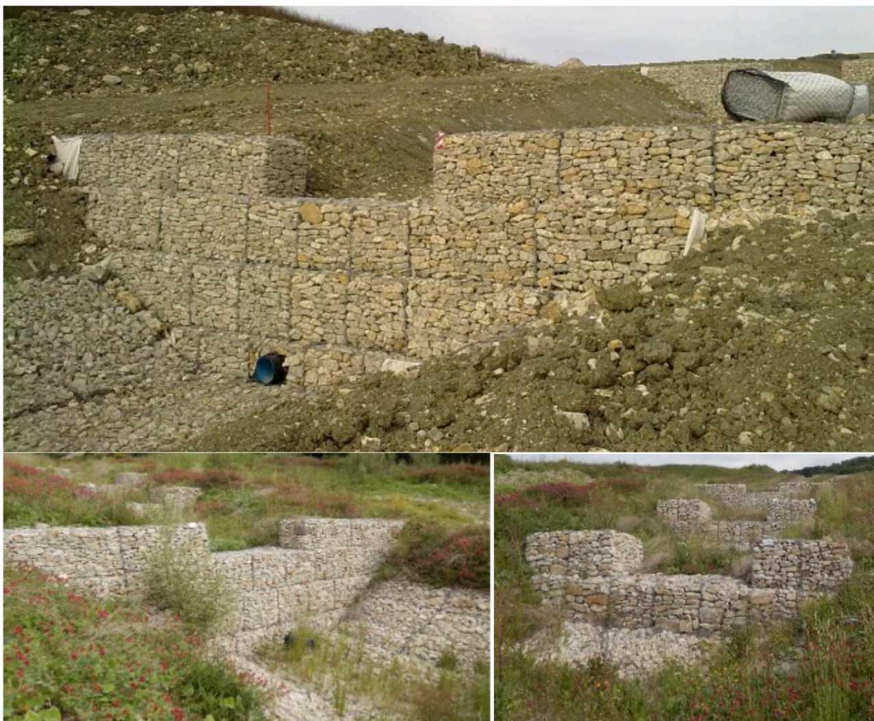
Figura 286 - Esempi di realizzazione di briglie in gabbionate riempite con materiale lapideo nei pressi della frana di Montaguto.
