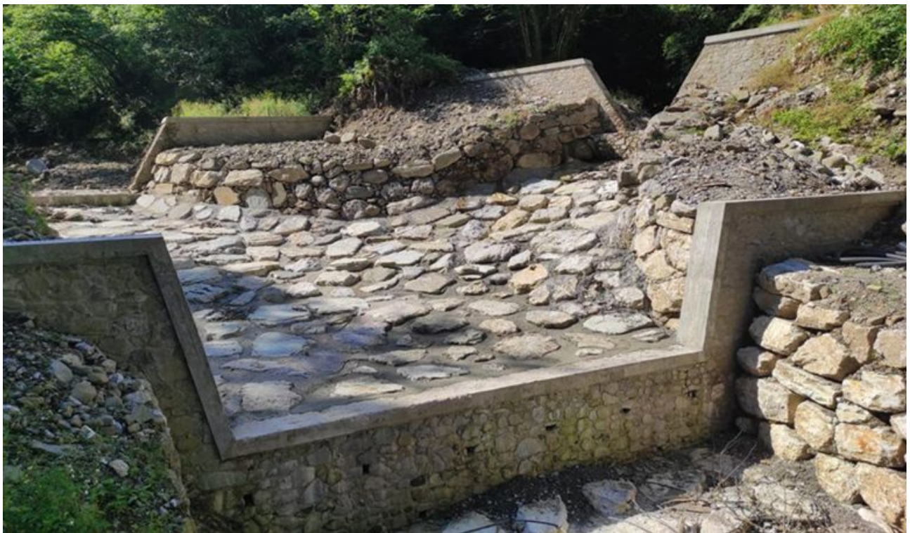
Figura 283 - Briglia in calcestruzzo armato su fondazioni profonde - Solco del Diavolo, Alta Garfagnana (LU).
