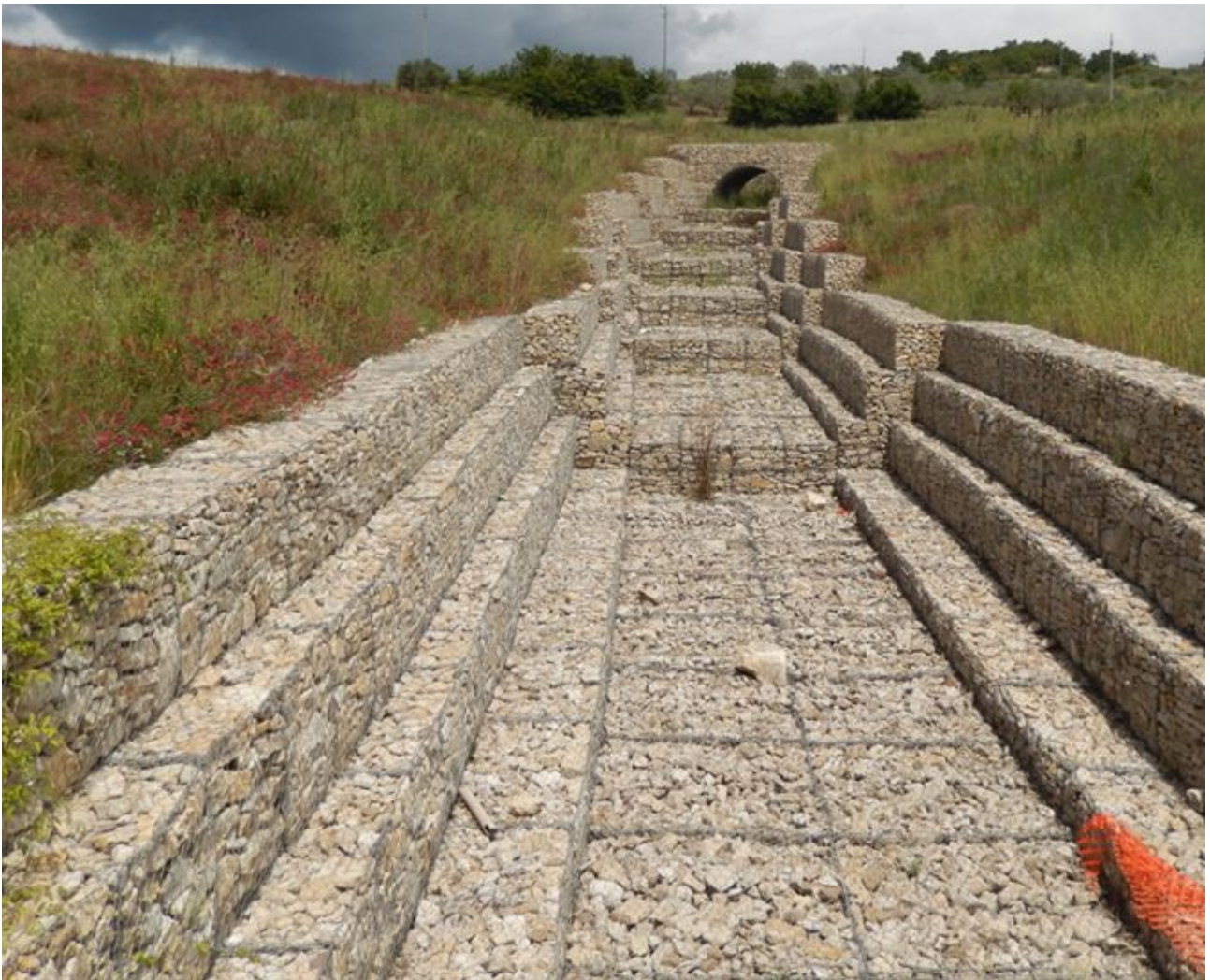
Figura 293 - Sistemazione alveo e sponde mediante utilizzo di gabbioni riempiti con materiale lapideo su un canale della frana di Montaguto.
