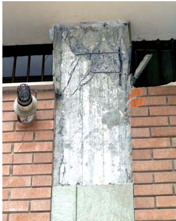
Fig. 8 – A sinistra, Cavezzo, 22 Maggio 2012: lesioni 3-4 al giunto di un condominio in c.a. del centro storico, successivamente crollato con la scossa del 29 Maggio. A destra, Mirandola, 21 Maggio: schiacciamento di un pilastro in c.a. in un condominio del centro storico.
