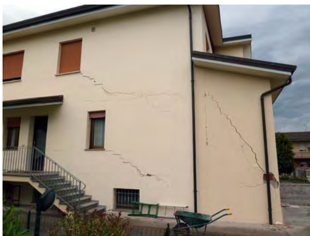
Fig. 9 – San Carlo. Cedimento differenziale di un edificio misto in c.a. e muratura per liquefazione con sviluppo di lesioni di livello 3. A destra, poco lontano, evidenze di liquefazione di sabbie eiettate da un pozzetto.
