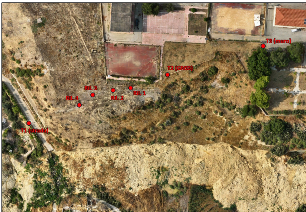
Figura 19 - Ubicazione dei capisaldi di monitoraggio della frattura in prossimità del plesso scolastico San Giuseppe: i punti Ril. 1-4 a cavallo della discontinuità e i riferimenti T1 (strada), T2 (GNSS), T3 (muro).
